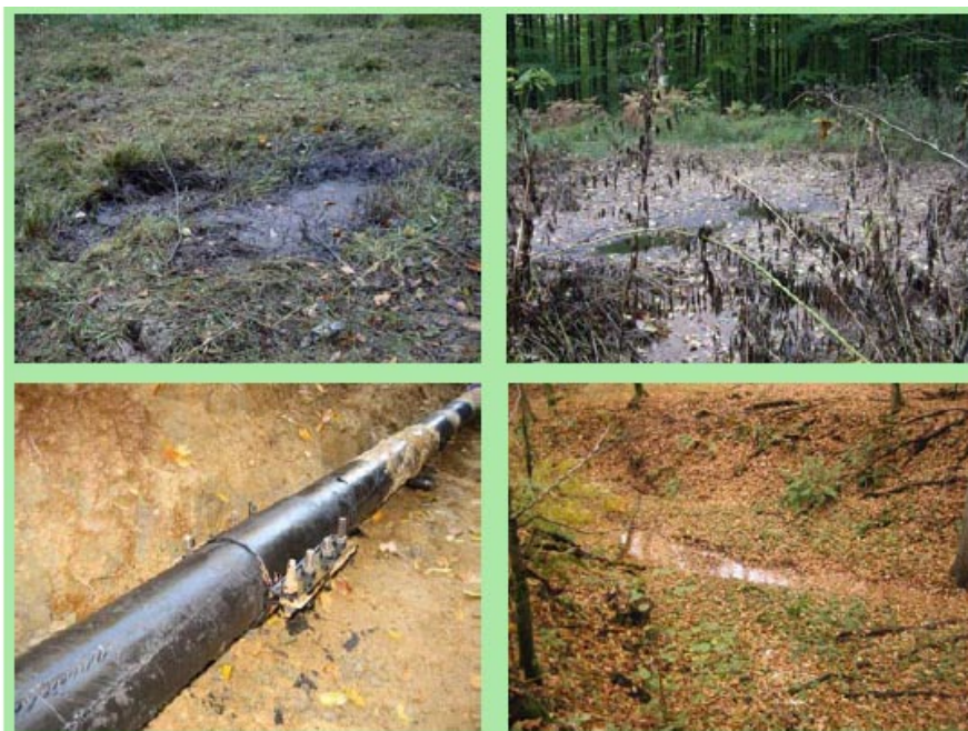
Slika 43. Posljedice propuštanja kolektorskog naftovoda na naftnom polju Jamarice, R. Hrvatska, 2009. (onečišćeno oko 500 m 2 šumskog tla) 119
